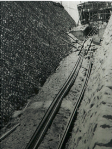
工事中の山頂駅付近。
