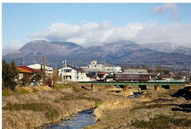
上毛電気鉄道の「デハ 101 号」と荒砥川橋梁
