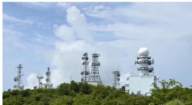
地蔵岳山頂の雨量観測用レーダー
