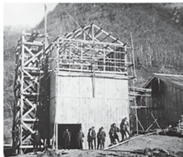
大沼の水を保管した氷室。エレベーターで中に落としていた
